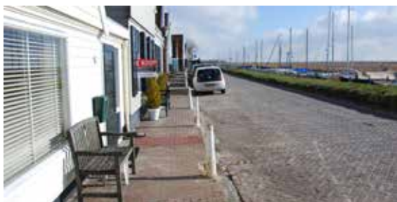
Karakteristieke opbouw: gevel - stoep - rijweg - tuimelkade
