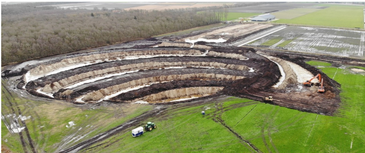
Aanleg viskringloop Wieringermeer
