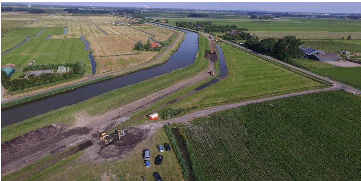
Foto: Verbetering boezemkade Schermer
