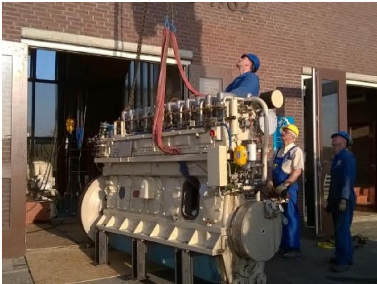
Foto: Einde dieseltijdperk gemaal Westerkogge
