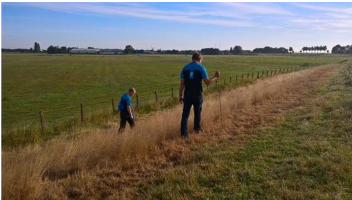
Foto: Dijkinspecties tijdens de droge warme zomer
