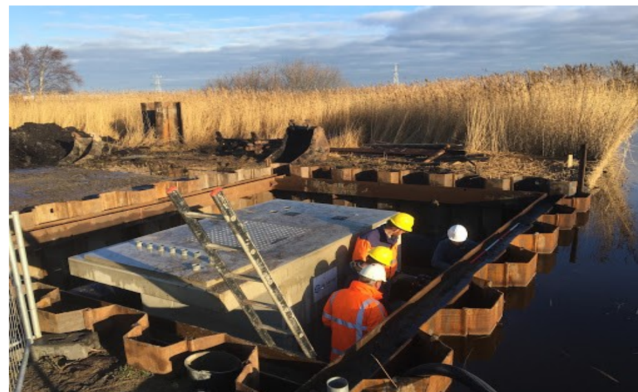
Foto: Aanleg vispassage gemaal Nauerna
