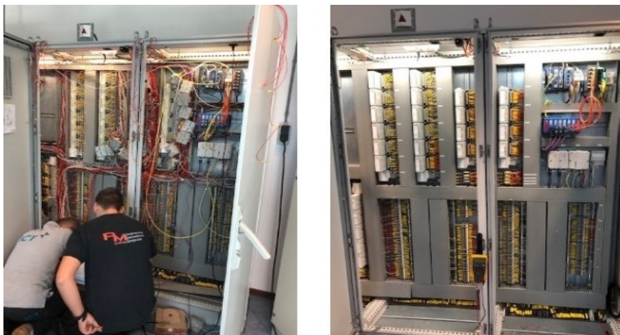
Foto: Vervangen procesautomatisering rwzi Heiloo, de besturingskast voor en na de ombouw
