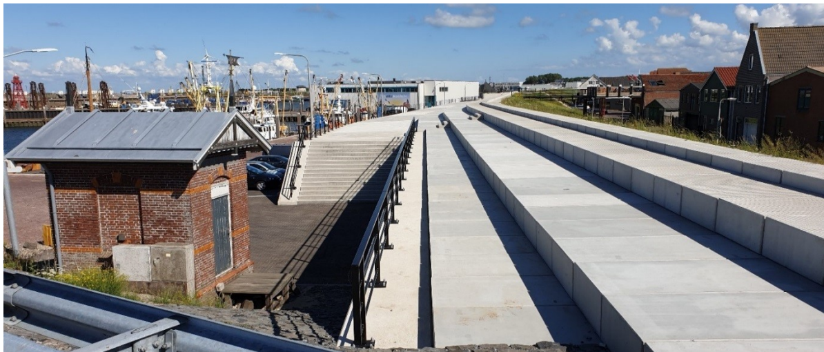
Foto: Versterking Hoogwaterkering Den Oever
