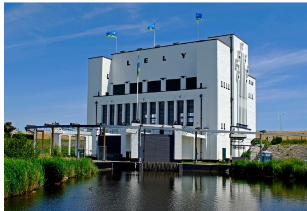
Foto: Renovatie aan gemaal Lely
