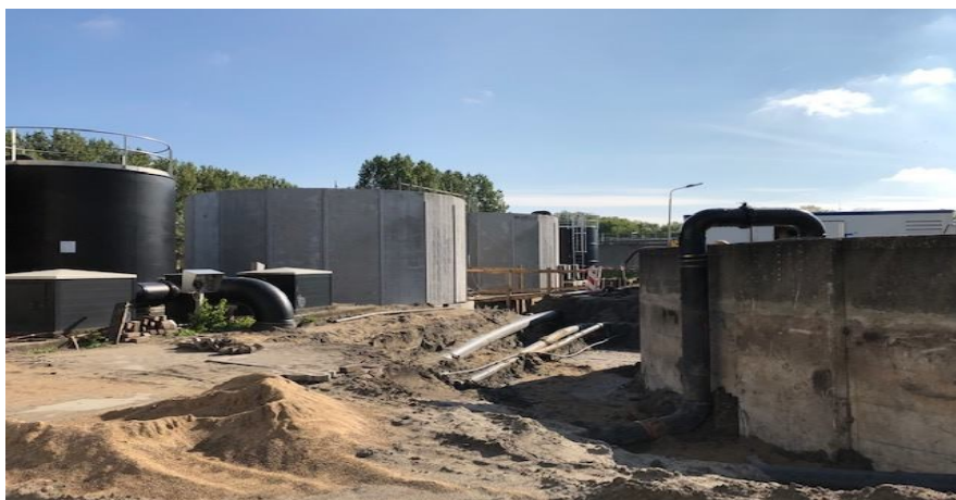
Foto: Bouw energiefabriek Zaandam-Oost
