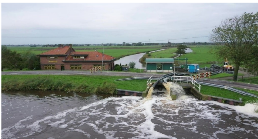
Foto: Noodbemaling Gemaal Willem Alexander, Driehuizen
