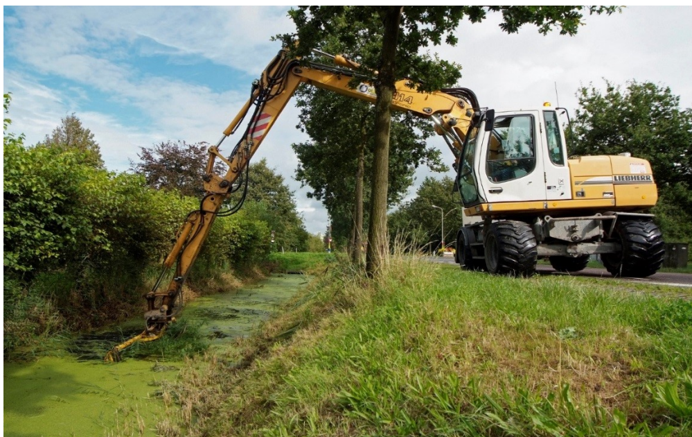
Foto: Werkzaamheden schone sloot
