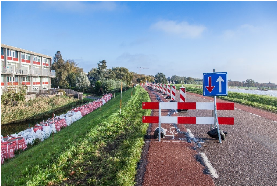
Foto: Scheurvorming Westerdijk Hoorn
