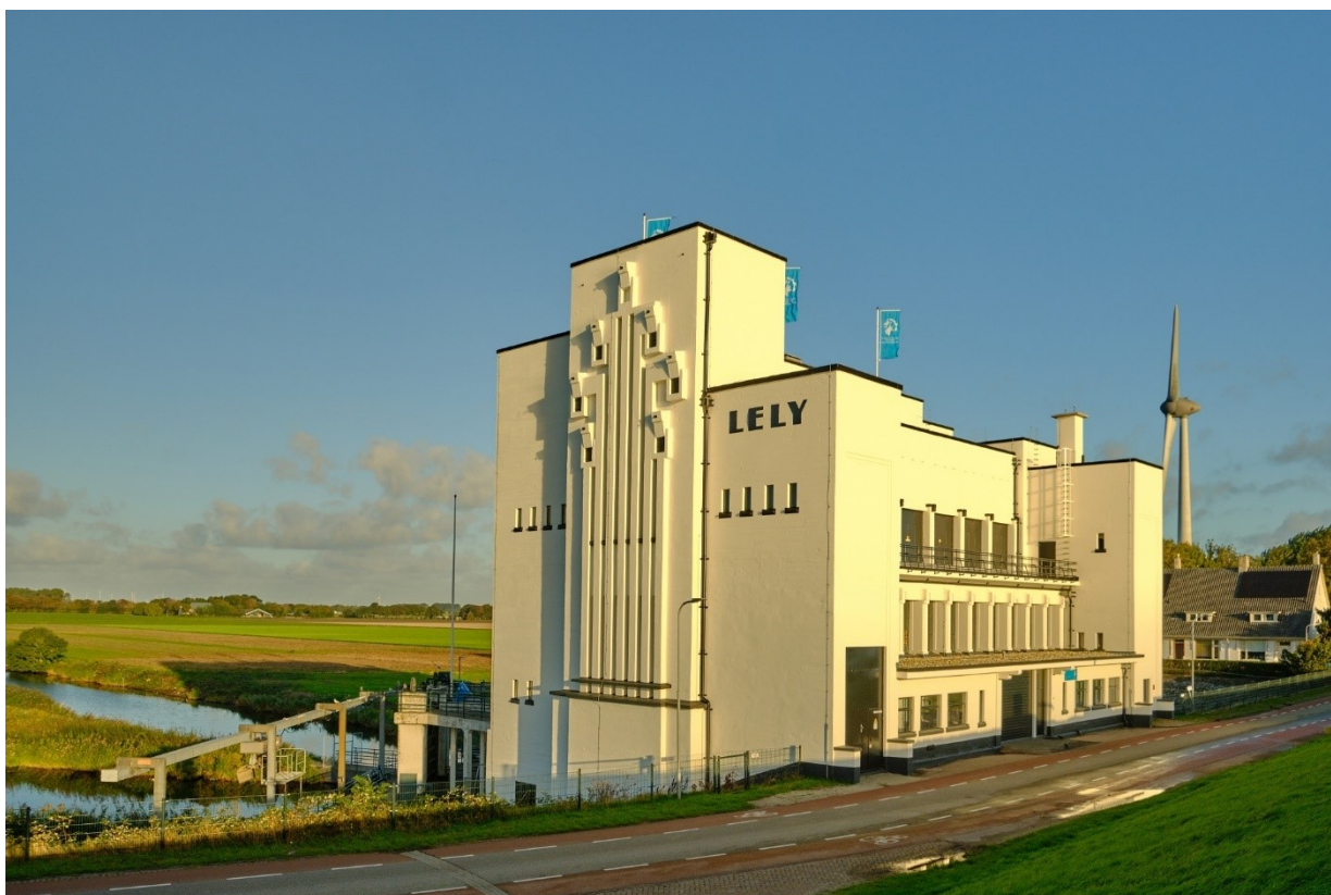
Foto: Gemaal Lely na grondige renovatie
