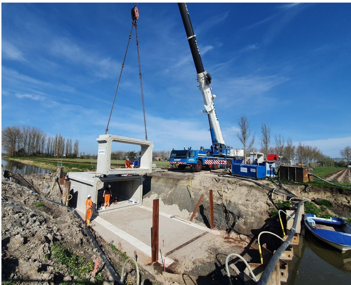
Foto: Plaatsing nieuwe duiker onder de Torenweg ter verbetering van het watersysteem van polder de Drieban
