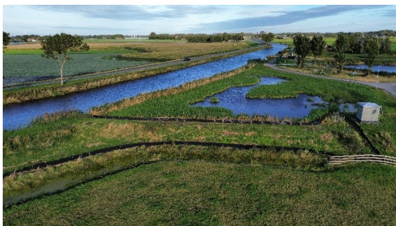
Het plaatsen van een paddenscherm ter bescherming van de rugstreeppadden bij onze werkzaamheden
