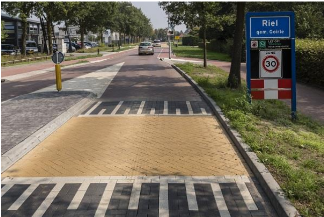
Drempel in betonstraatstenen
