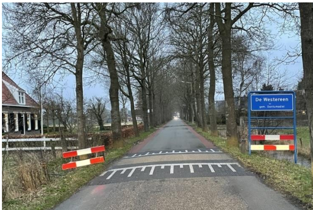
Drempel in betonstraatstenen
