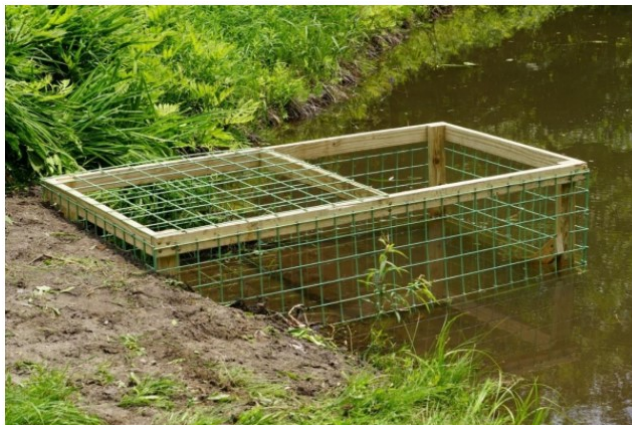
Figuur 5.10. Kooi met gaas voor een duiker om te voorkomen dat bevers het dichtstoppen met takken en modder. Bij de oever is de bovenzijde dicht om te voorkomen dat de dieren van boven af materiaal inbrengen.
