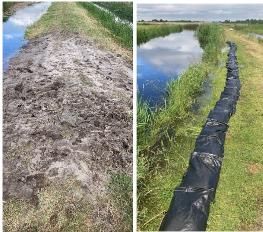
Figuur 2.4. Zandzakken op dijkje bij gemaal Maalwater (Heiloo).
