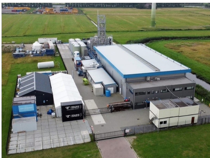
Abbeelding 6.5. De proefinstallatie van bedrijf SCW systems op bedrijventerrein Boekelermeer in Alkmaar.
