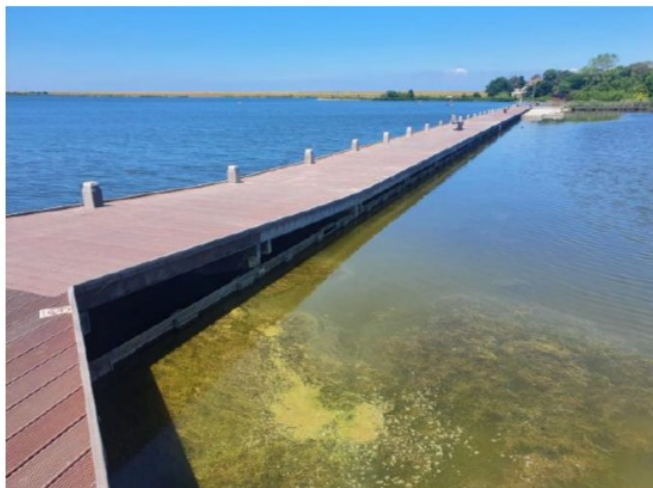
Afbeelding 5.5 De steiger met damwand die Lutjestransd afsluit van het Amstelmeer. Op de voorgrond is blauwalg zichtbaar.
