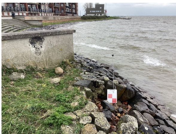
Afbeelding 2.3. Het gat in de steenbekleding bij Visserseiland te Hoorn.
