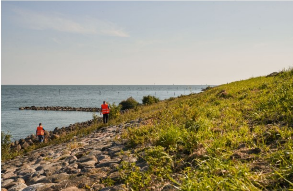
Afbeelding 2.3. Visuele inspectie primaire kering.
