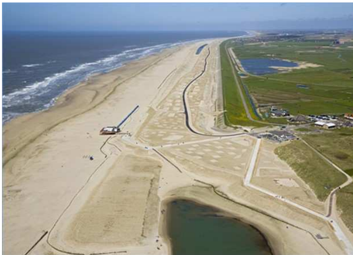
Figuur 2.13. Aanleg van de Hondsbossche Duinen. Goed zichtbaar zijn het (slingerende) fietspad en de zogenaamde luwe laagtes. Deze laagtes worden gevormd door de lichter gekleurde rechthoeken. Ze zijn bedoeld om plaatselijk verstuiving te bevorderen als voorwaarde voor een gezonde helmvegetatie.
