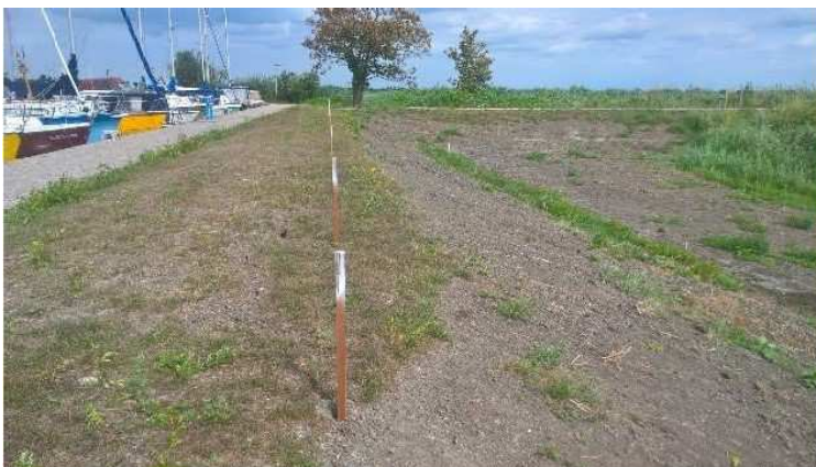
Figuur 2.4. Zichtlijn met piketpaaltjes bij jachthaven Zwaansmeer. Met deze paaltjes wordt vervorming van de dijk gecontroleerd.
