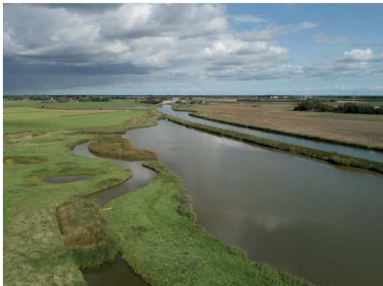
Figuur 5.10. luchtfoto van één van de onderzochte oevers in kanaal Omval - Kolhorn.
