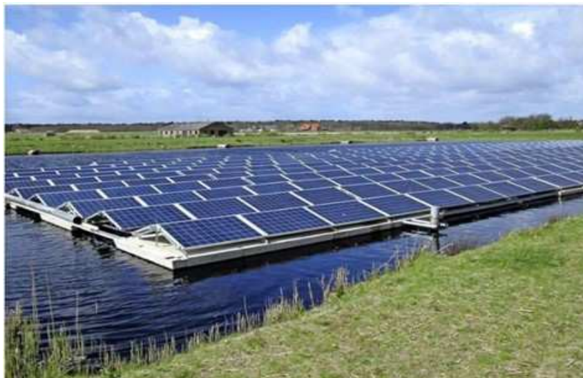
Figuur 6.6. Op de rwzi Everstekoog liggen zonnepanelen bij het helofytenfilter.
