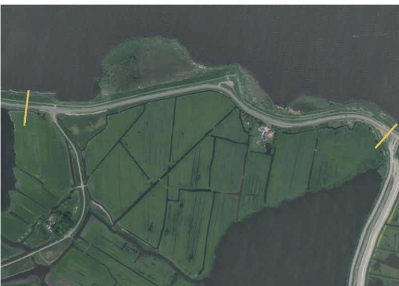
Figuur 2-7. Luchtfoto dijkvak 9.
