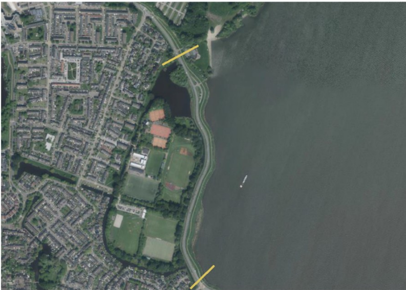
Figuur 2-3. Luchtfoto dijkvak 5.
