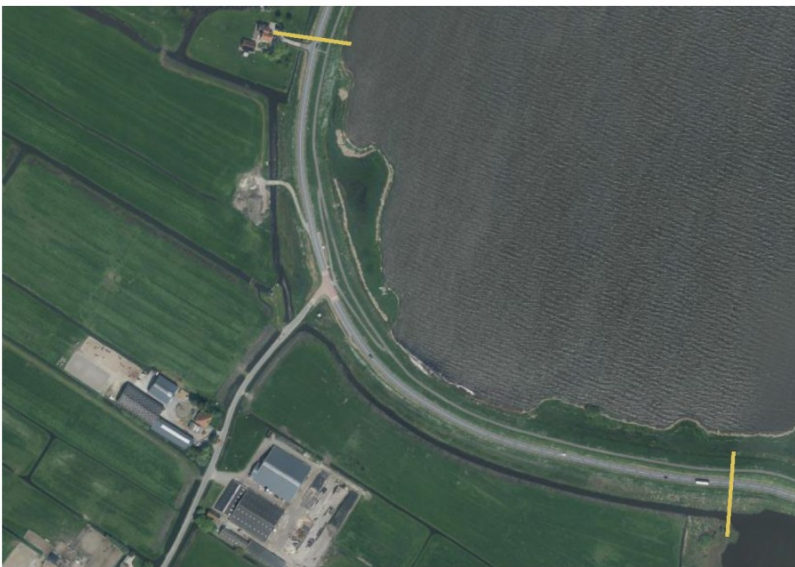
Figuur 2-5. Luchtfoto dijkvak 7.
