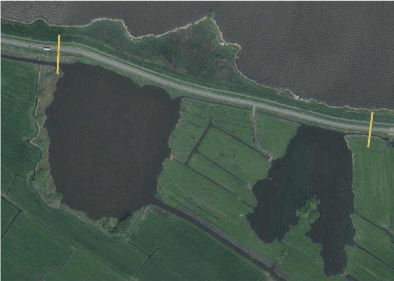
Figuur 2-6. Luchtfoto dijkvak 8.
