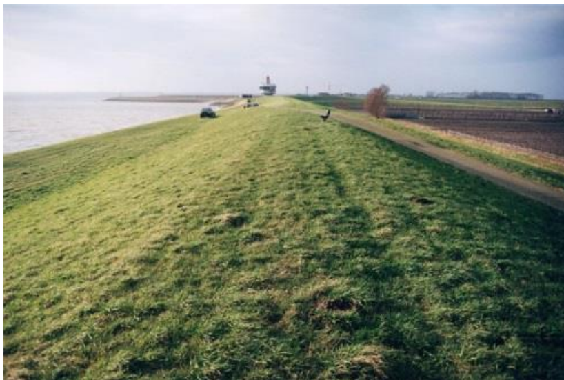
Figuur 1.1 Gras op waterkering langs Westerschelde
