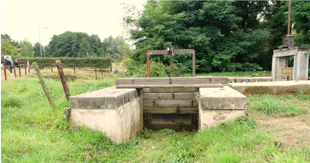
Verdeelwerk met molensluis en rechts de lossingsluis.
