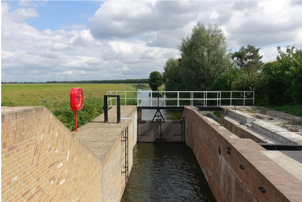
De Keenesluis vanaf de brug over het buitenhoofd.
