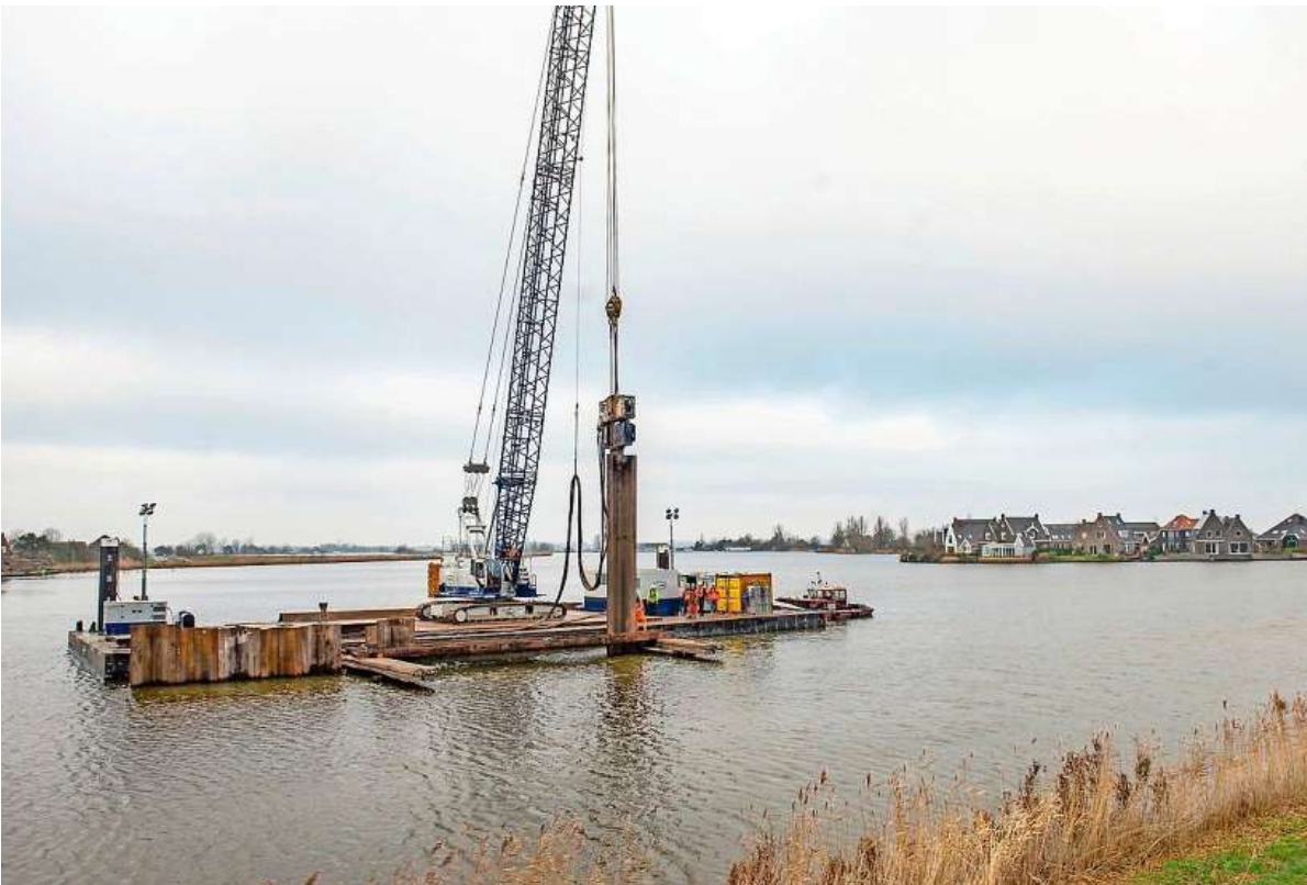
Er worden damwanden geslagen voor een zandpakket waar later het gemaal komt.
