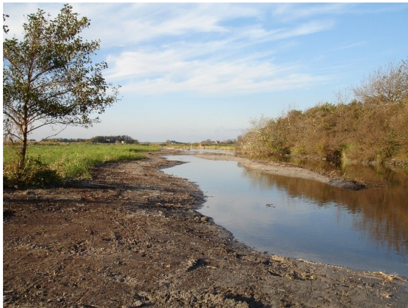
Aanleg van een natuurvriendelijke oever.
