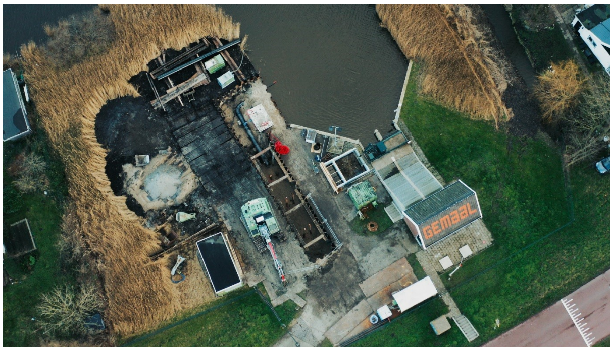
Vispassage gemaal Nauerna.
