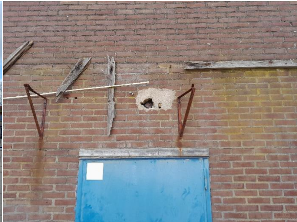
Figuur 3.11: Detailfoto gat in buitengevel.
