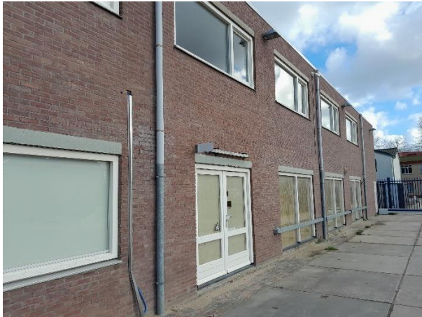
Figuur 3.10: Buitengevel vleermuisgeschikte bedrijfshal.
