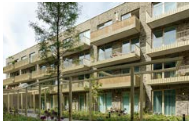
Elementen zoals balkons en andere geveltoevoegingen sluiten qua kleur aan op het hoofdmateriaal.
