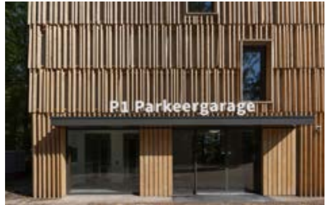
Beide langsgevels van de parkeergarages worden op de begane grond voorzien van een met de architectuur mee-ontworpen entree voor voetgangers.
