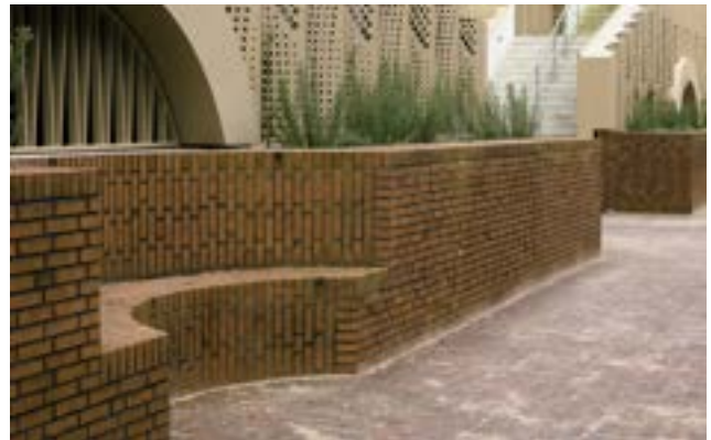
Het ondersteel deel van de plint wordt uitgevoerd in baksteen en voorzien van zitelementen en groenvakken - Parkeerhuis Nijmegen (ontwerp: Korthtielens architecten).
