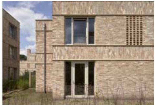
Zijgevels die zichtbaar zijn aan de openbare ruimte worden waar mogelijk voorzien van royale gevelopeningen- Strijp R, Eindhoven (ontwerp: Happel Cornelisse Verhoeven).
