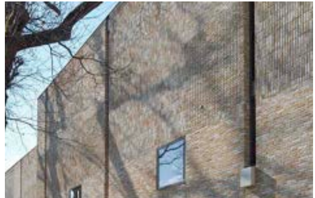
Verrijking gevel door subtiele variatie in metselwerkverbanden - Strijp R, Eindhoven (ontwerp: Bedaux de Brouwer architecten).
