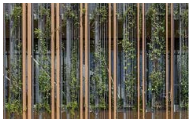
De vergroening is onderdeel van het gevelontwerp en versterkt het verticale karakter van de gevels - Tsukuba Japan (ontwerp: Toda)
