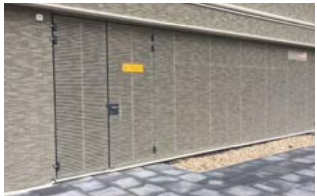
Entrees van technische ruimtes zijn onopvallend onderdeel van het gevelontwerp - UMCG Groningen (ontwerp: Aas architecten).
