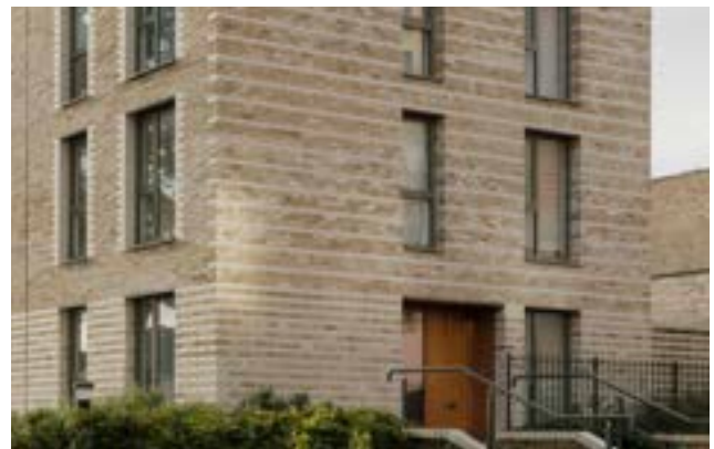
Kopgevels die grenzen aan de openbare ruimte hebben een verzorgde gevelindeling - Evolution South, Londen (ontwerp: Maccreanor Lavington).
