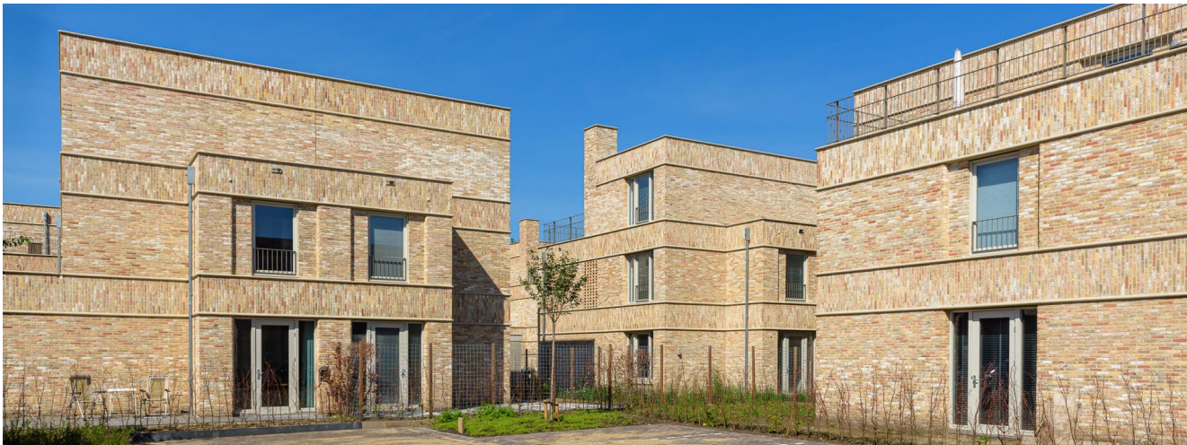
Verbijzonderingen in het metselwerk zorgen voor geleiding en versterken het detailniveau
