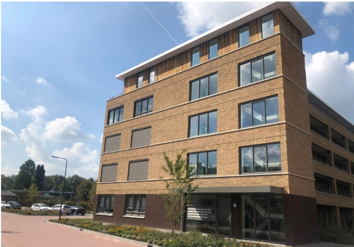
Verzorgde kopgeles, setback versterkt de geleding, metselwerk heeft licht gele genuanceerde kleur
