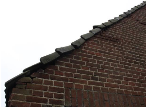
Afbeeldingen 15 en 16: Kantpannen van de aangrenzende schuur (1) en container (4).
