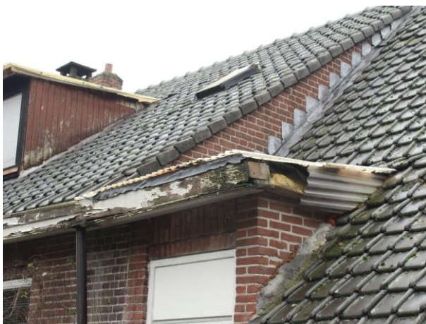
Afbeeldingen 36 en 37: Openingen aan de zijkant van de bebouwing en scheve kantpannen.
