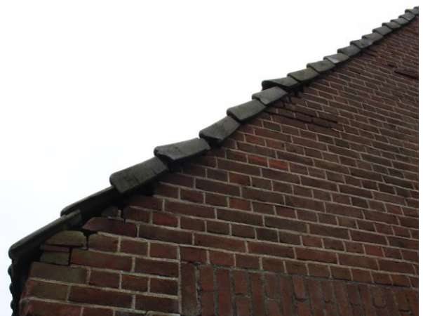
Afbeeldingen 36 en 37: Openingen aan de zijkant van de bebouwing en scheve kantpannen.
