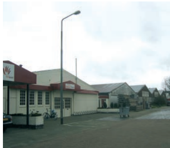
11. Loodsen aan Voltaweg
