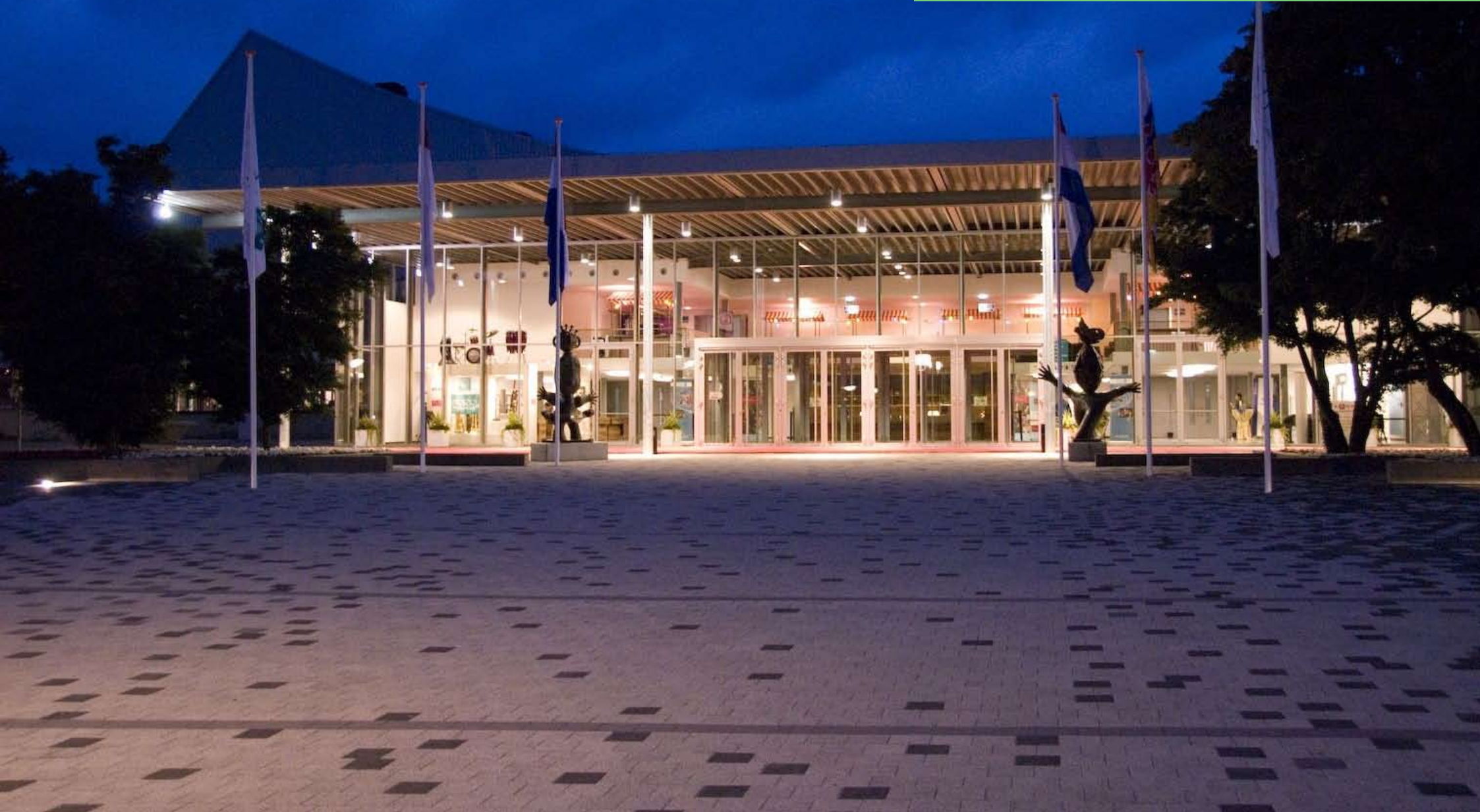
(Bild) Die erneuerte Rodahalle
