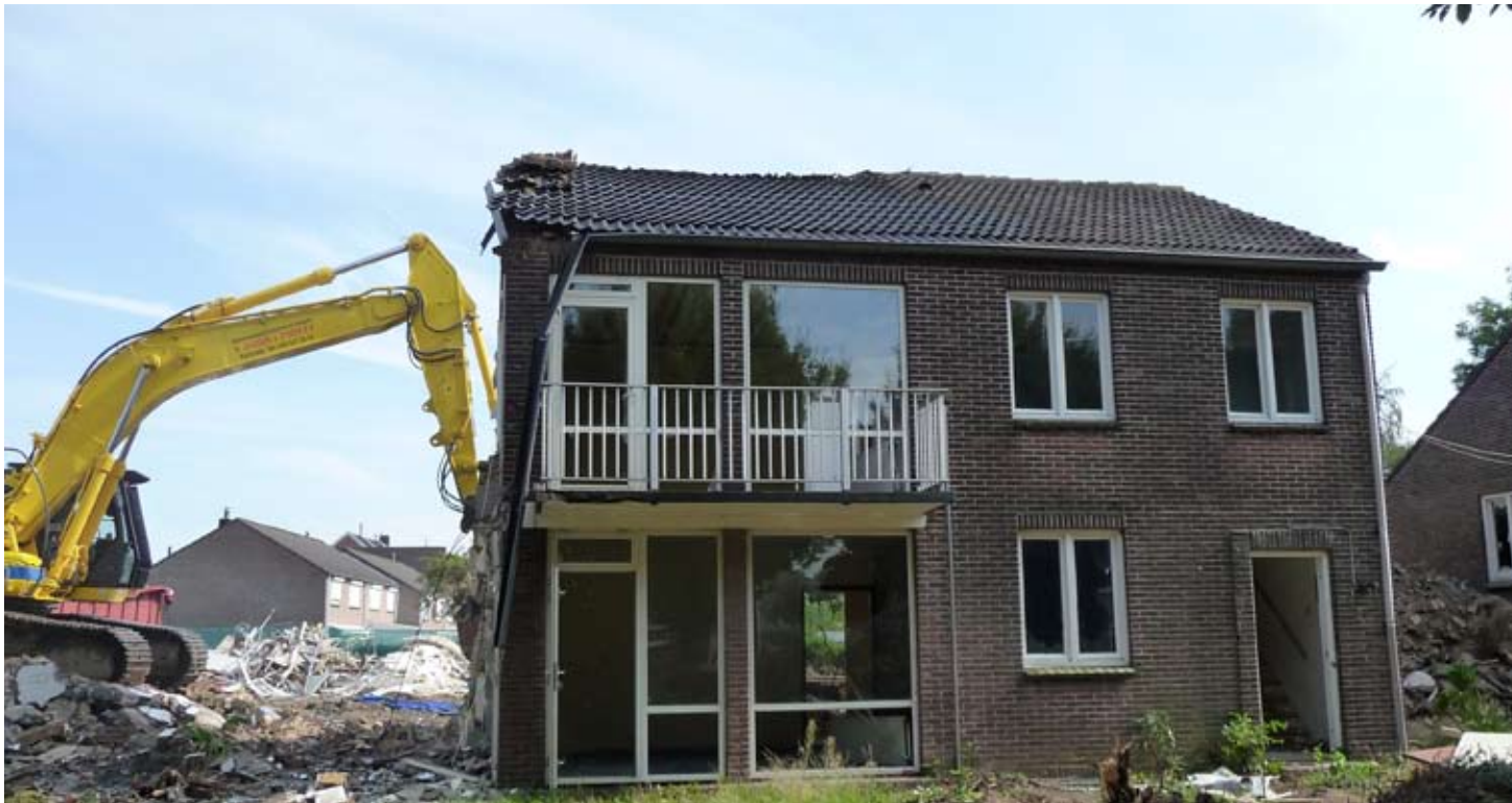
Abriss Duplex-Wohnung Ecke Kommerveldlaan – Laurastraat
