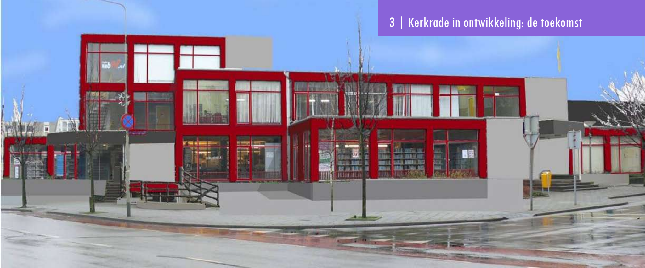
Socioproject Eygelshoven na renovatie, impressie (bron: Arcadis)
