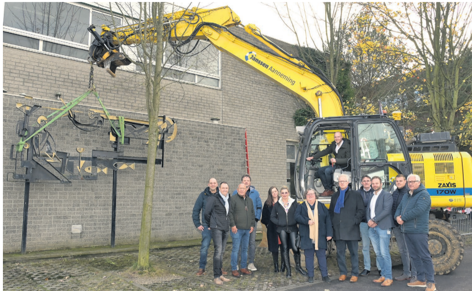
Wethouder Tim Weijers (Ruimtelijke ordening & Vastgoed) geeft samen met het betrokken team van ambtenaren het startsein voor de bouwwerkzaamheden voor Flexiforum II
