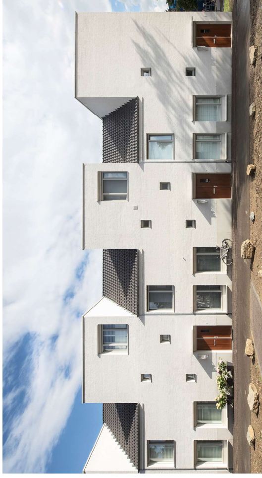
Referentieproject Klevarie, Polverpark, Maastricht, MWHA: diepe negges, luifel en verlichting bij entree, zinken goten en hemelwaterafvoeren, vrije gevelindeling
