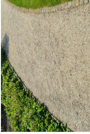
Gebonden halfverharding als bestrating van het plein
