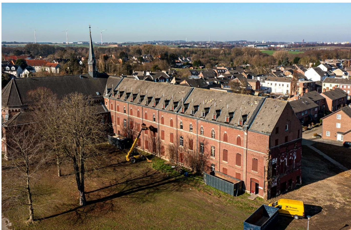
Verbouwing voormalig Klooster Pannesheide
