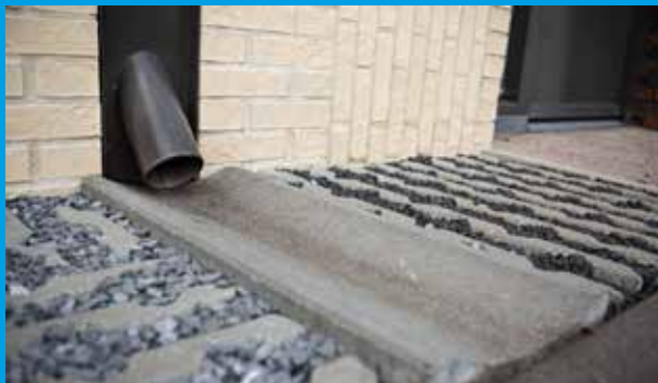
Afkoppelen schoon regenwater
