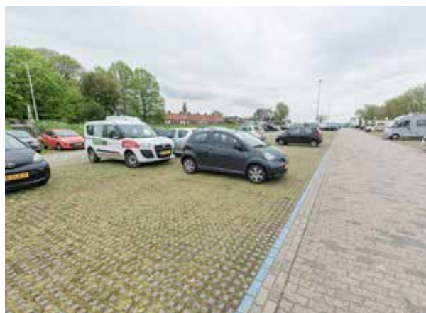
Met waterdoorlatende stenen voorkomen we wateroverlast en verdroging van de bodem
