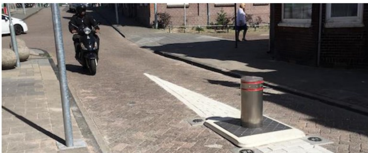
Figuur 18: Fysiek dynamische knip met poller
