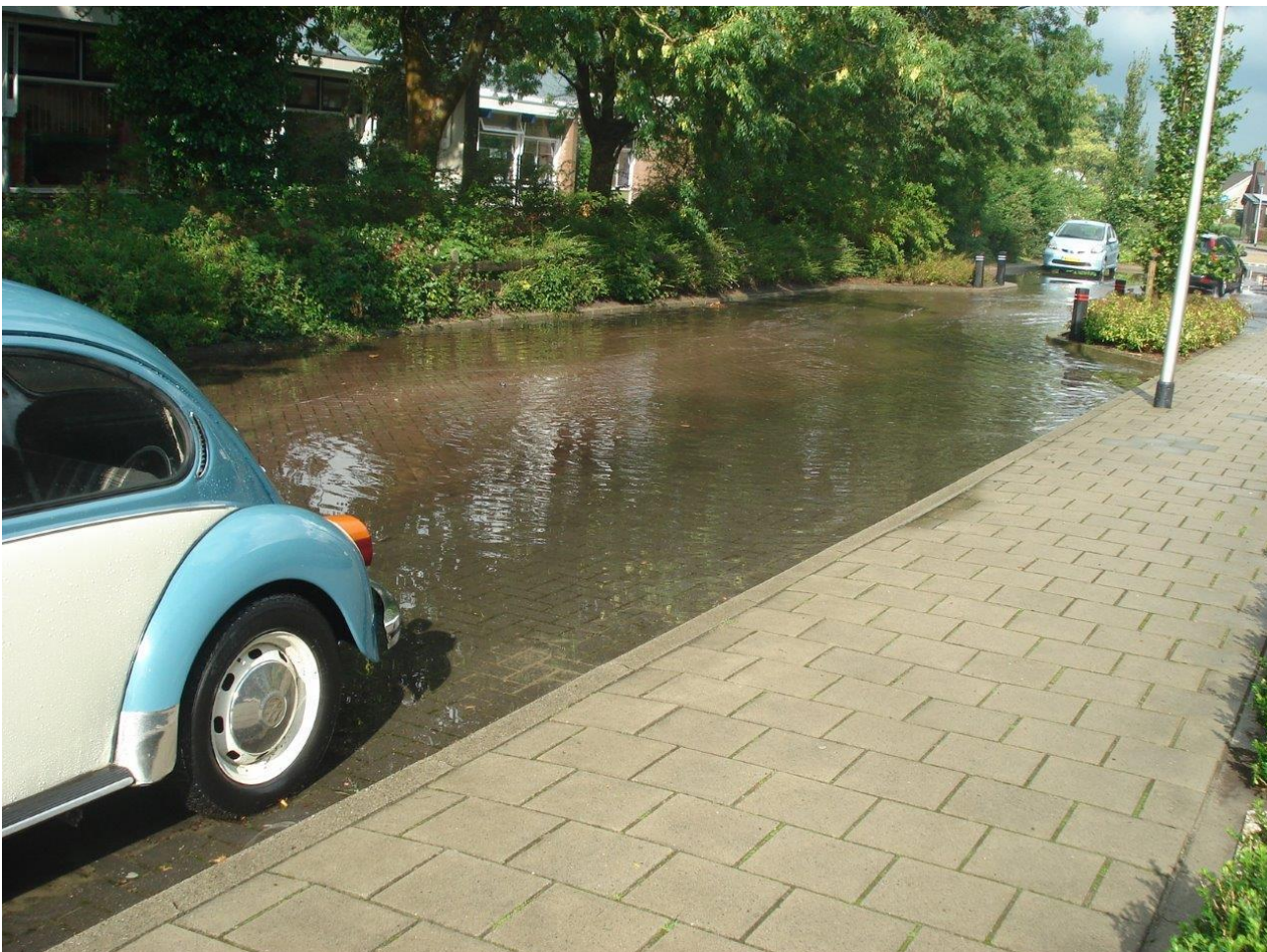
Figuur 3: Water op straat in de vorm van hinder (verkeer is nog net mogelijk)
