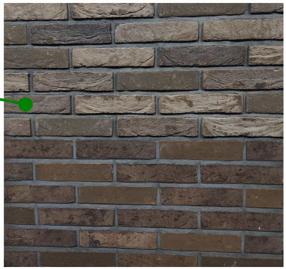
nummer 36A - metselwerk: Bruin-grijskl. - Kozijnen: Hout, RAL 7022 - Gevelbekleding: Hout, Zwart - Overstek: Hout, RAL 7044
