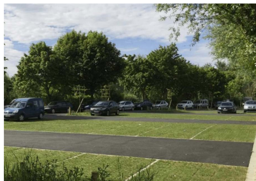
asfalt als rijloper
