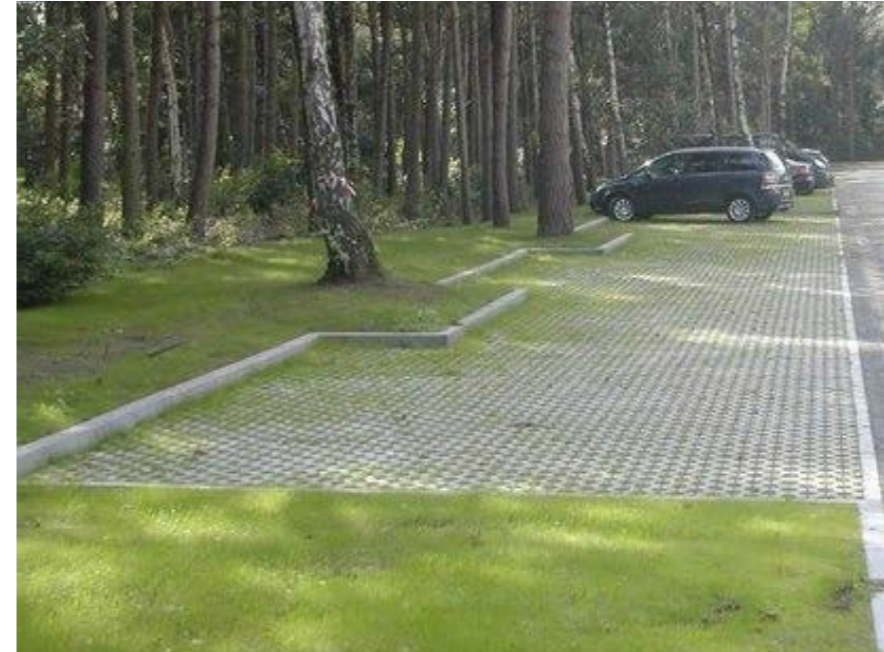
entree: parkeren in het groen (grasbetonstenen) en grijze asfaltverharding
