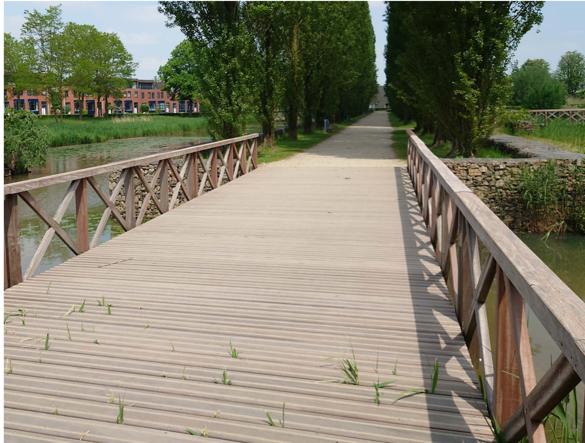
referentie brug over brede watergang als bijzonder element
