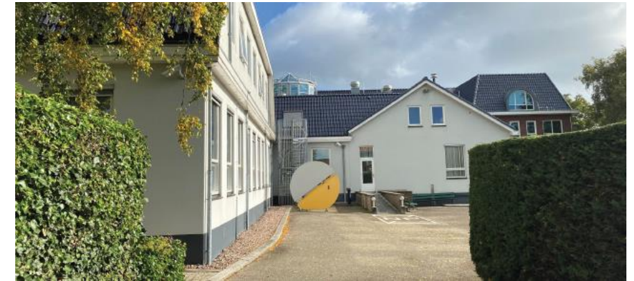
Figuur 2.3: Zicht op achtergevel vanaf binnenplein
