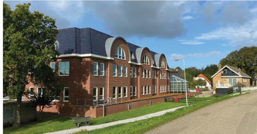
Figuur 2.1: Zicht op het oostelijke deel van het bouwvolume dat evenwijdig is gelegen aan de IJsselmeerdijk
