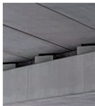
Referentiebeeld vleermuis-verblijfplaats onder brug
