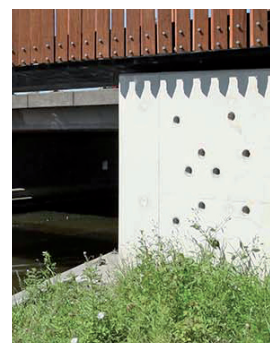
Referentiebeeld zwaluwgaten in brug
