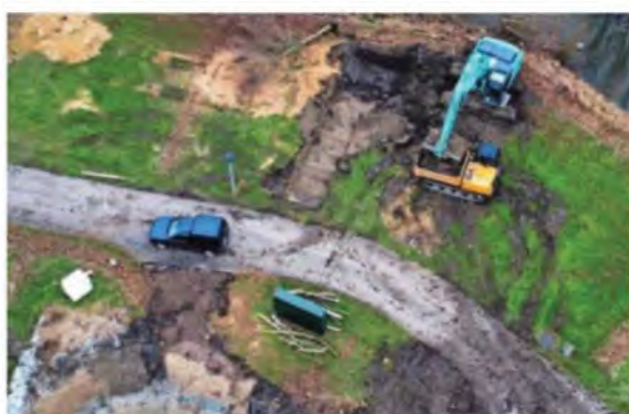
Kranen en graafmachines op rupsbanden laten diepe sporen na op het grasveld van de camping. FOTO AANGELEVERD
