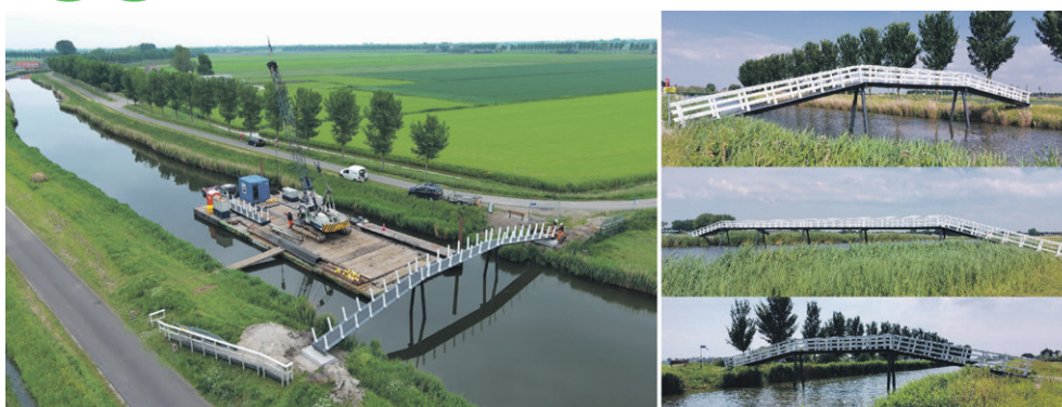
Links: de nieuwe brug over de Beemsterringvaart in aanbouw. Rechts: de drie nieuwe bruggen.
