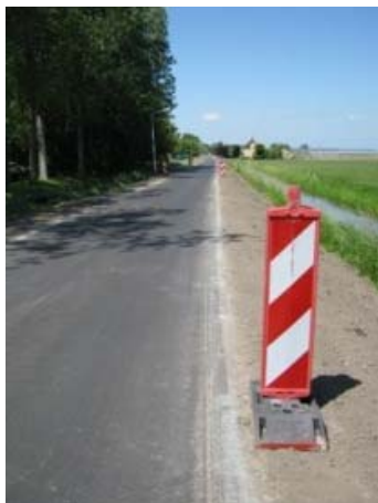
Wegwerkzaamheden in Koggenland
