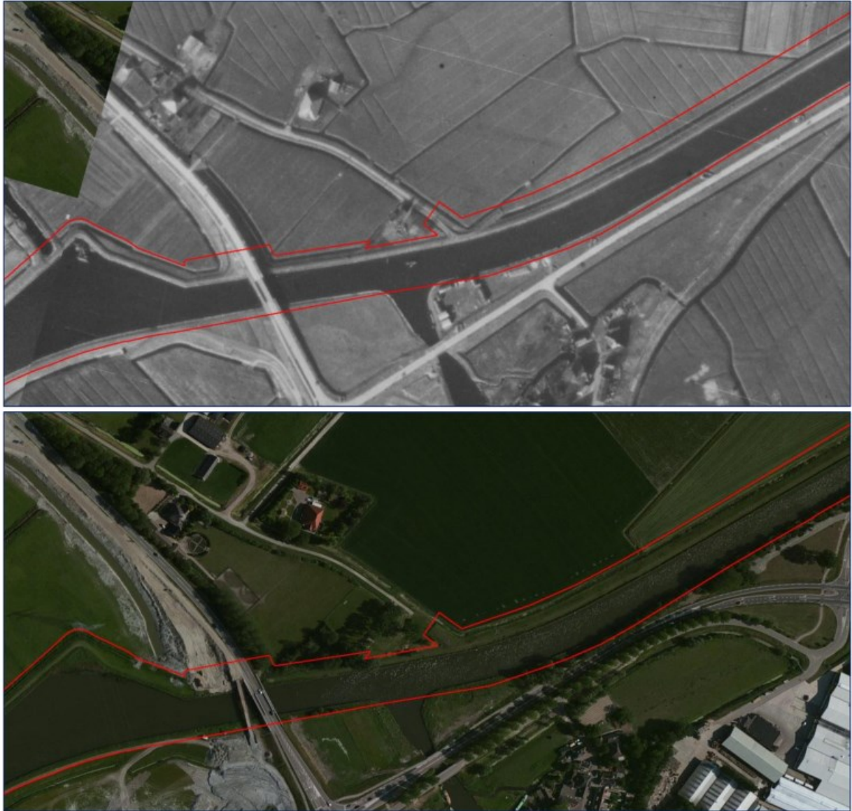
Figuur 18: Opnamen van het kanaal Alkmaar (Omval) – Kolhorn ter hoogte van de Rolpaalbrug. Op de luchtopnamen is te zien dat de brug reeds in de oorlog aanwezig was. De satellietbeelden tonen dat er werkzaamheden nabij de brug hebben plaatsgevonden. Zowel ten noorden als ten zuiden van het onderzoeksgebied is nieuwe infrastructuur aangelegd en zijn verschillende gebouwen verrezen.
