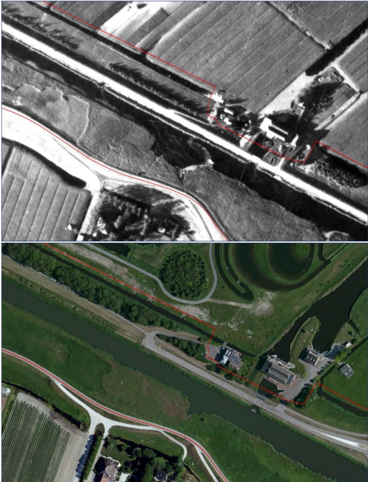
Figuur 22: Opnamen van de Ringvaart van de Heerhugowaard ter hoogte van kilometer 1.0 (K8). Op basis van een vergelijking van de beide opnamen zijn enkele kleine verschillen in de oevers van de waterloop zichtbaar.
