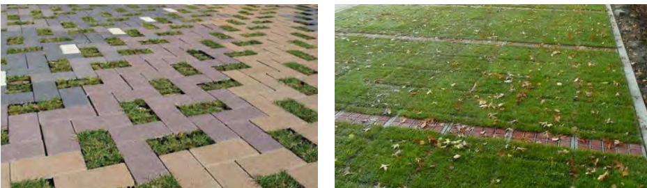
voorbeelden toepassing grasbetonstenen en ritterplaten
