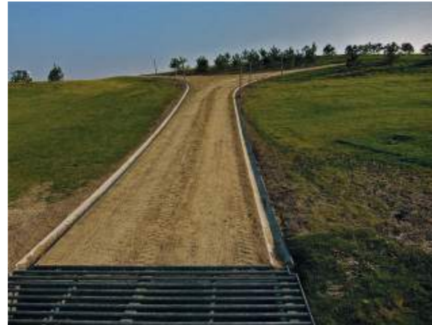
afwerking paden met gebonden halfverharding
