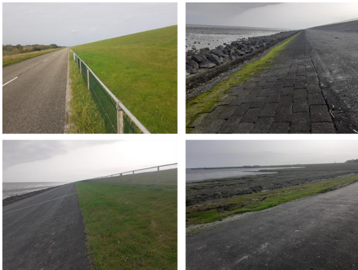
Foto 2-2 Impressie van de Landelijke dijk (binnendijs met onderhoudsweg defensie (Kustweg) en buitendijs met teenbestorting-asfaltbekleding (ook onderhoudsweg/fiets-voetpad) en grasbekleding
