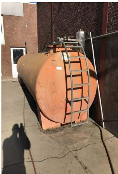
Foto 7. Bovengrondse dieseltank
