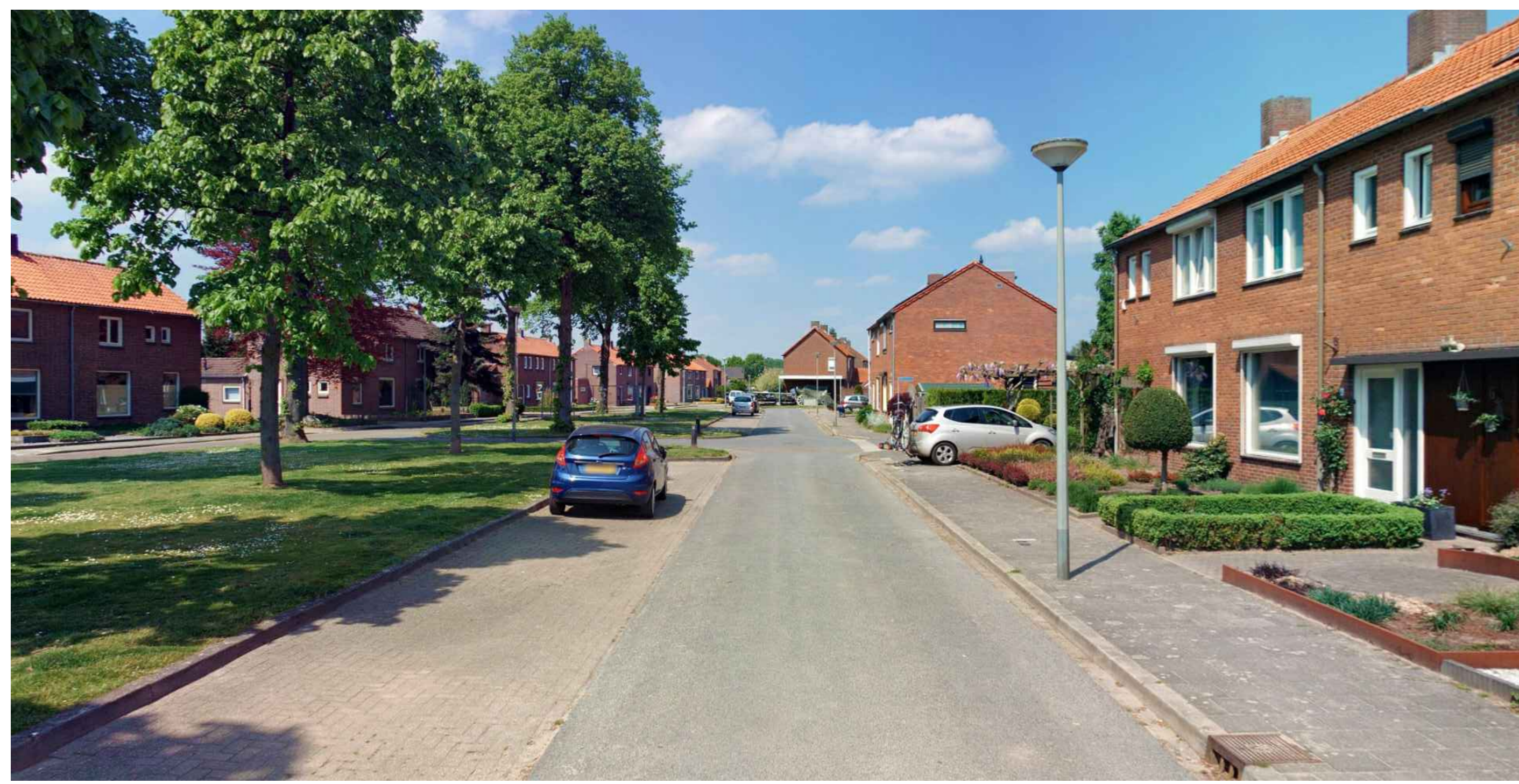
Locatie: Lindenstraat nr. 4 - Bestaande situatie
