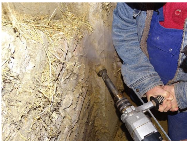
Afb. 3.7 Het boren van gebintstijl 1
