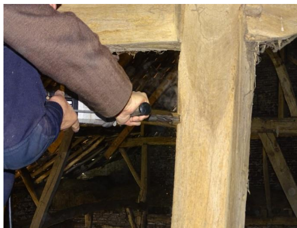
Afb. 3.8 Het boren van gebintstijl 3
