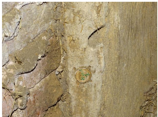
Afb. 3.14 Het afdichten van het boorgat met een eiken stop
