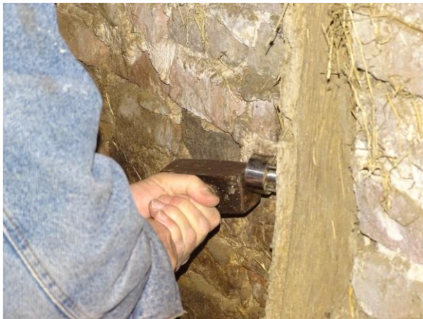
Afb. 3.3 Aanbrengen rondstalen boormal
