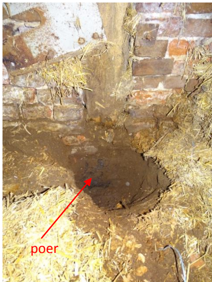
Afb. 3.16 Ontgraven natuurstenen poer onder ankerbalkgebint 1
