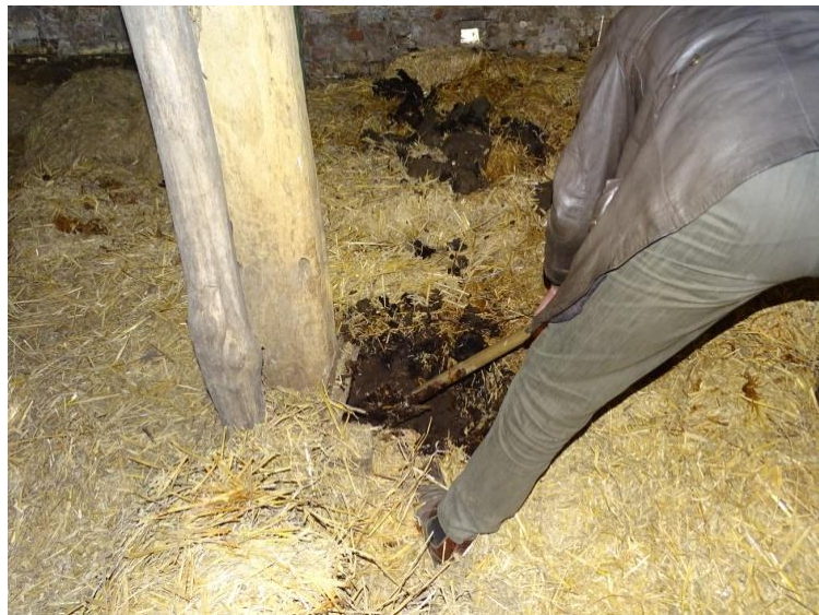
Afb. 3.17 Het ontgraven van de natuurstenen poer onder ankerbalkgebint 2
