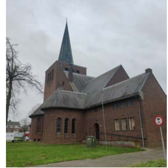
Afbeelding 17 Exterieur, gezien vanuit het zuidoosten
