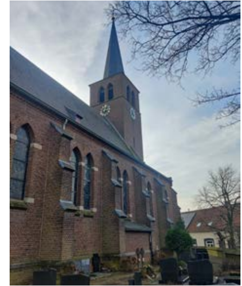
Afbeelding 81 Exterieur, gezien vanuit het noordoosten
