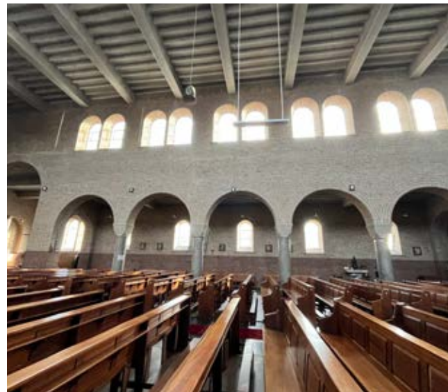
Afbeelding 94 Interieur, zicht richting zuiderlijke zijbeuk
