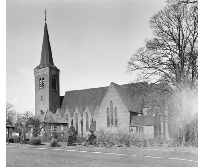
Afbeelding 103 Exterieur, gezien vanuit het westen omstreeks 1937 [Beeldbank RCE]
