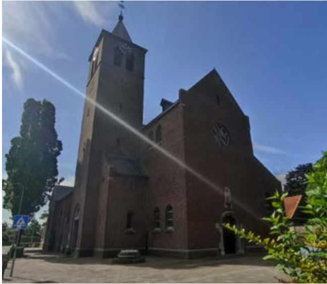
Afbeelding 143 Exterieur, gezien vanuit het noordwesten
