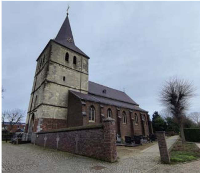
Afbeelding 122 Zicht vanuit het zuidwesten op het oude gedeelte
