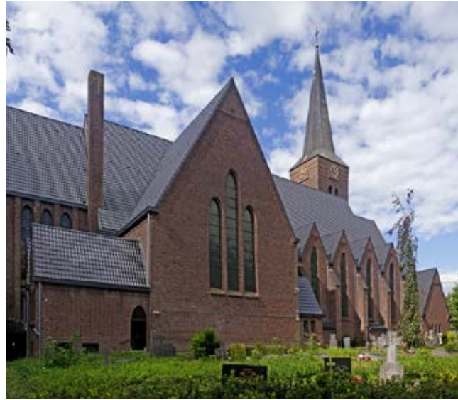
Afbeelding 102 Exterieur, gezien vanuit het noordoosten
