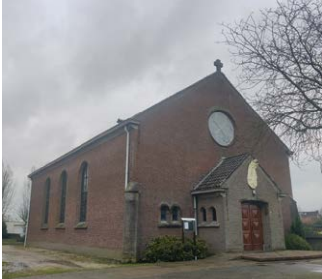
Afbeelding 153 Exterieur, gezien vanuit het noordwesten
