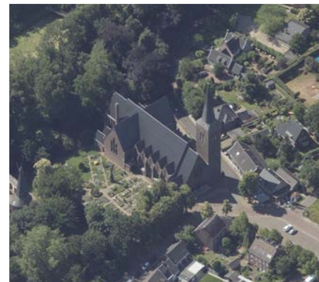
Afbeelding 98 Luchtfoto vanuit het noorden
