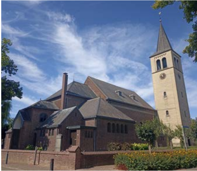
Afbeelding 133 Exterieur, gezien vanuit het noordoosten
