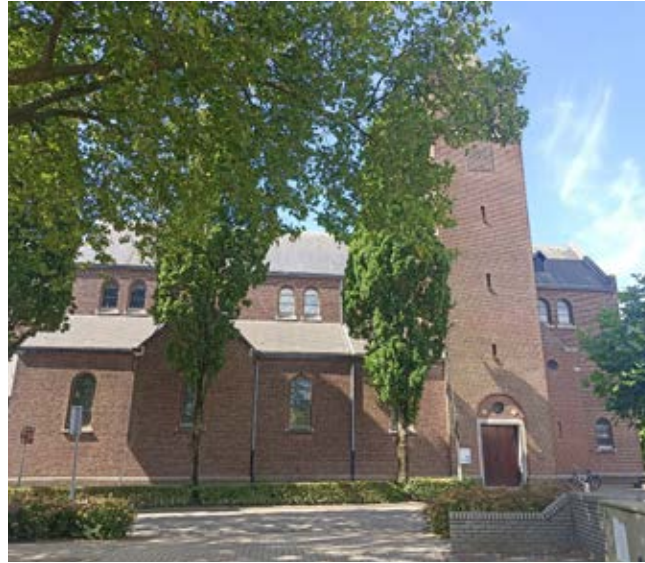
Afbeelding 144 Exterieur, gezien vanuit het noordoosten
