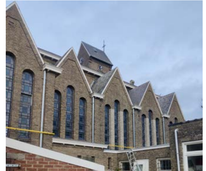
Afbeelding 115 Zicht op de topgevels van de zijbeuk
