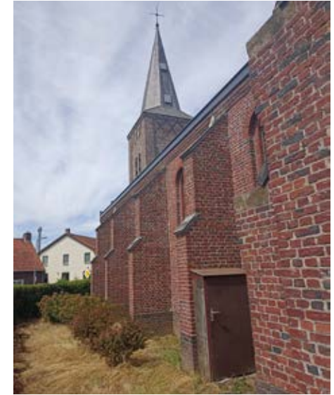
Afbeelding 165 Exterieur, gezien vanuit het zuidoosten
