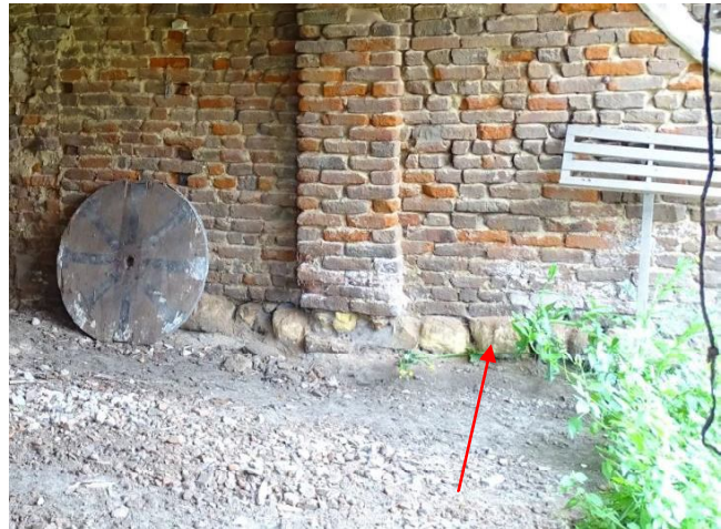
Afb. 4.3 Koenrader blokken onder de tussenmuur
