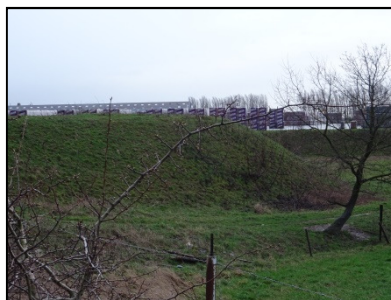
Figuur 4. Detailfoto van grondwal waarop noordelijke windturbine gerealiseerd wordt.
