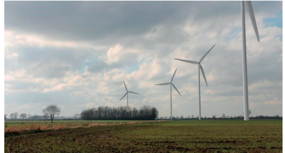
Figuur 5: Windpark op een afstand van 5 keer de tiphoogte; de windturbines zijn beeldbepalend en zeer dominant aanwezig.
