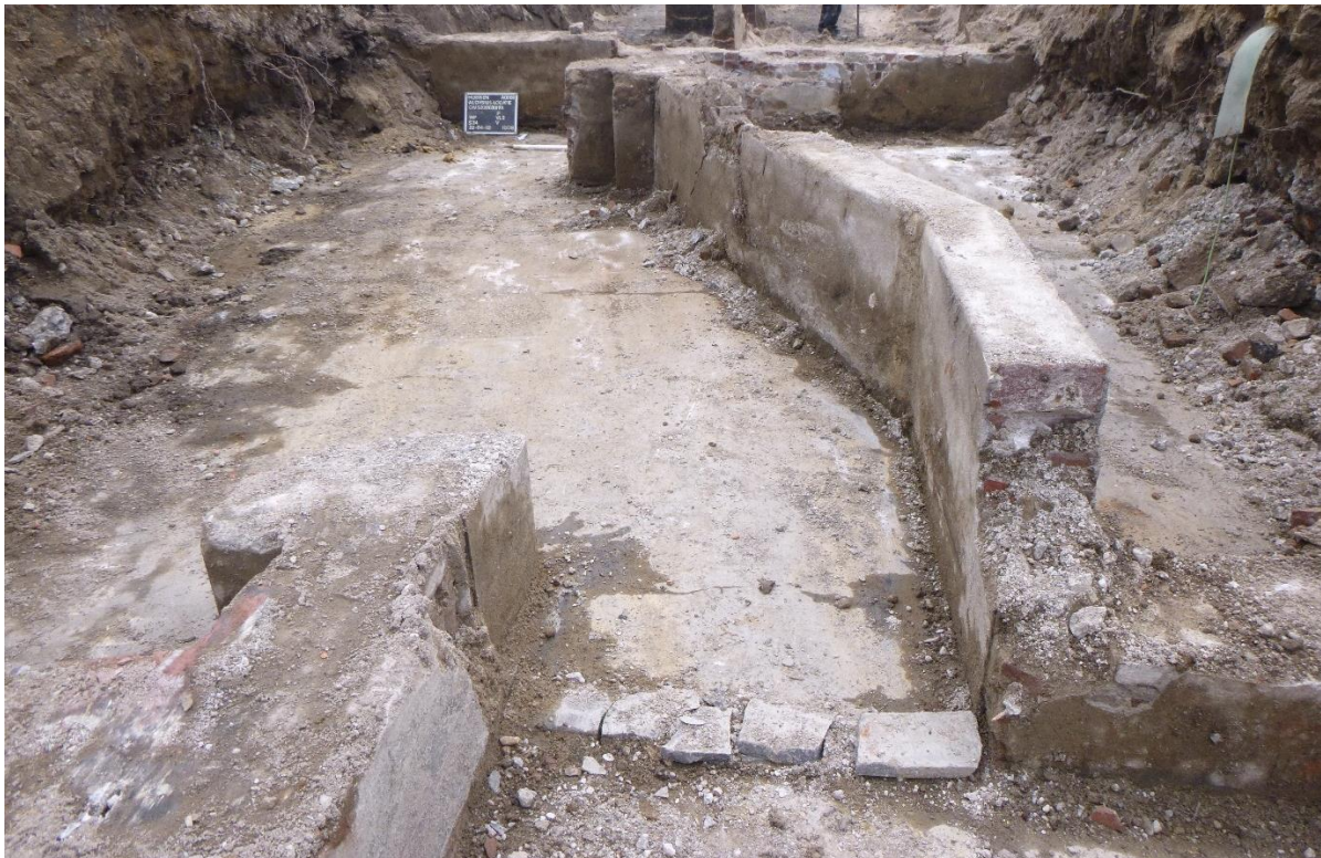
Figuur 10. De kelder S34 in WP4, richting het zuiden gefotografeerd.
