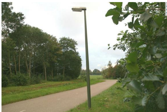
Foto CROW: scheefstaand \leq 3 graden per lichtmast
