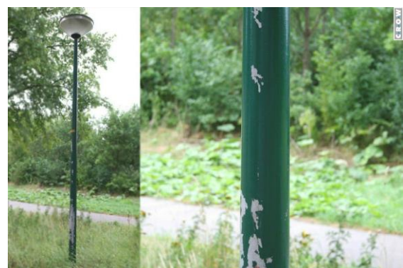
Foto CROW: dekkingsgraad coating \geq 95\% per lichtmast
